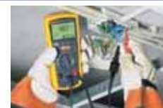
Test okablowania w małej skrzynce rozdzielczej — wszystko w jednym miejscu
