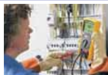
Test izolacji na panelu rozdzielczym
